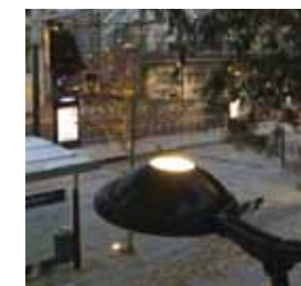
Armatuur met indirecte verlichting voor groenaanlichting.
