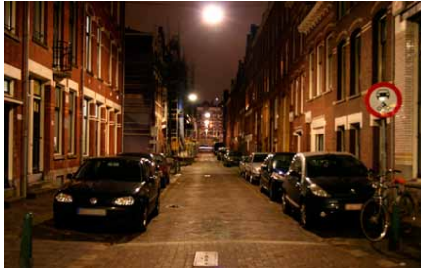
Staatvoorbeeld met hangende armaturen.
